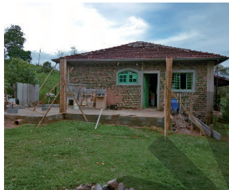
Casa construída com garrafas PET, em Extrema (MG). Foto de 2020.
