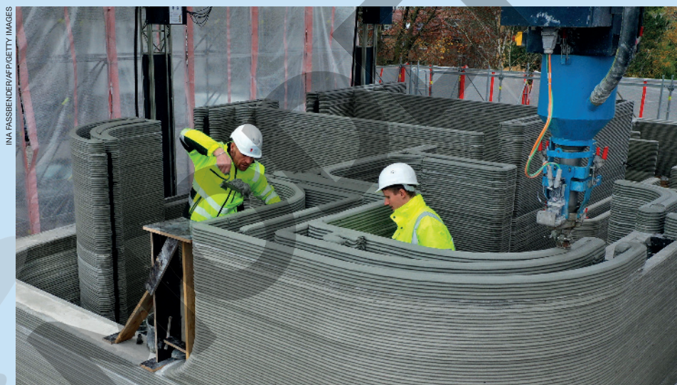
Impressora 3D, à direita na foto, aplicando camadas de concreto na construção de uma casa em Beckum, Alemanha, 2020.
